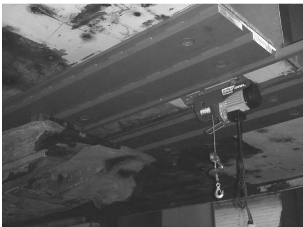
Rys.1. Wzmocnienie stropu stanowiska do badań kinematyki i funkcjonalności sekcji obudowy zmechanizowanej [2]
